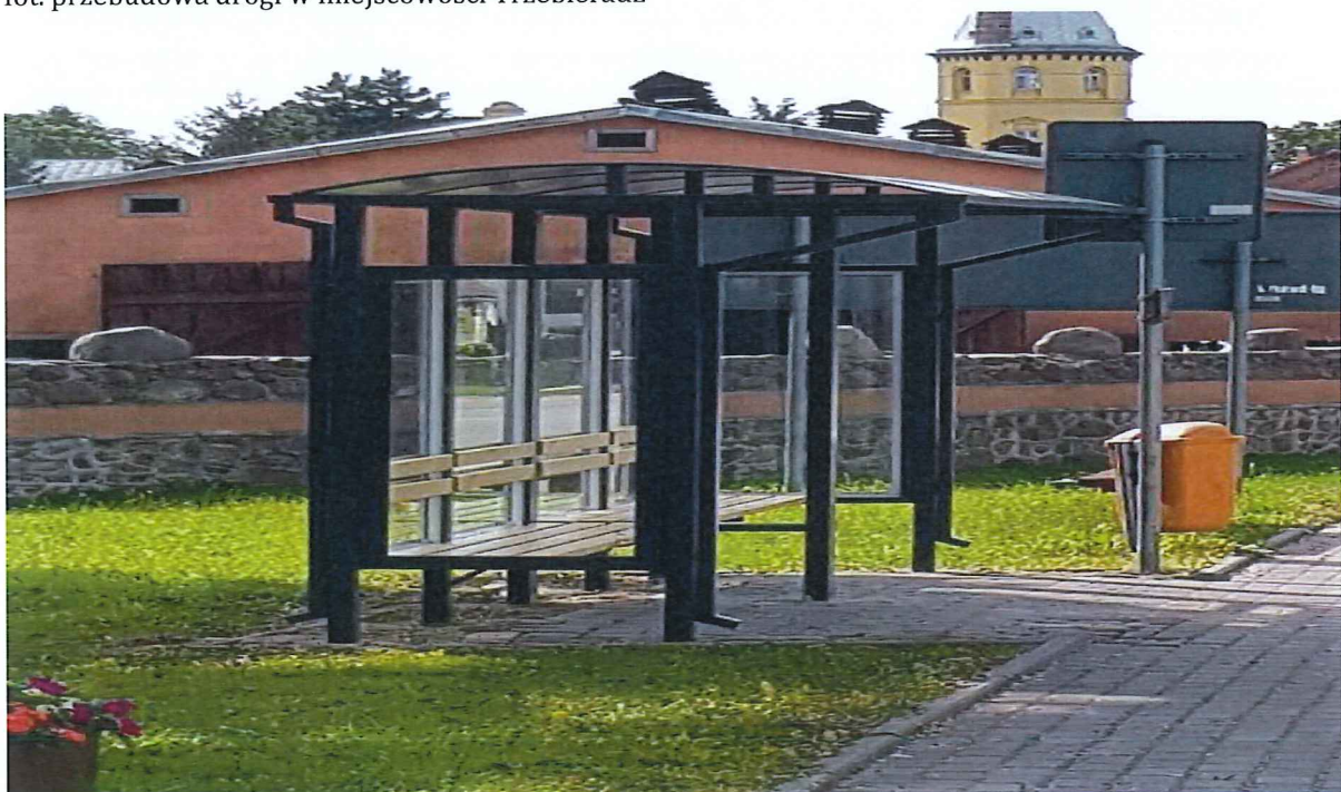
fot. remont przystanku w miejscowości Stuchowo
