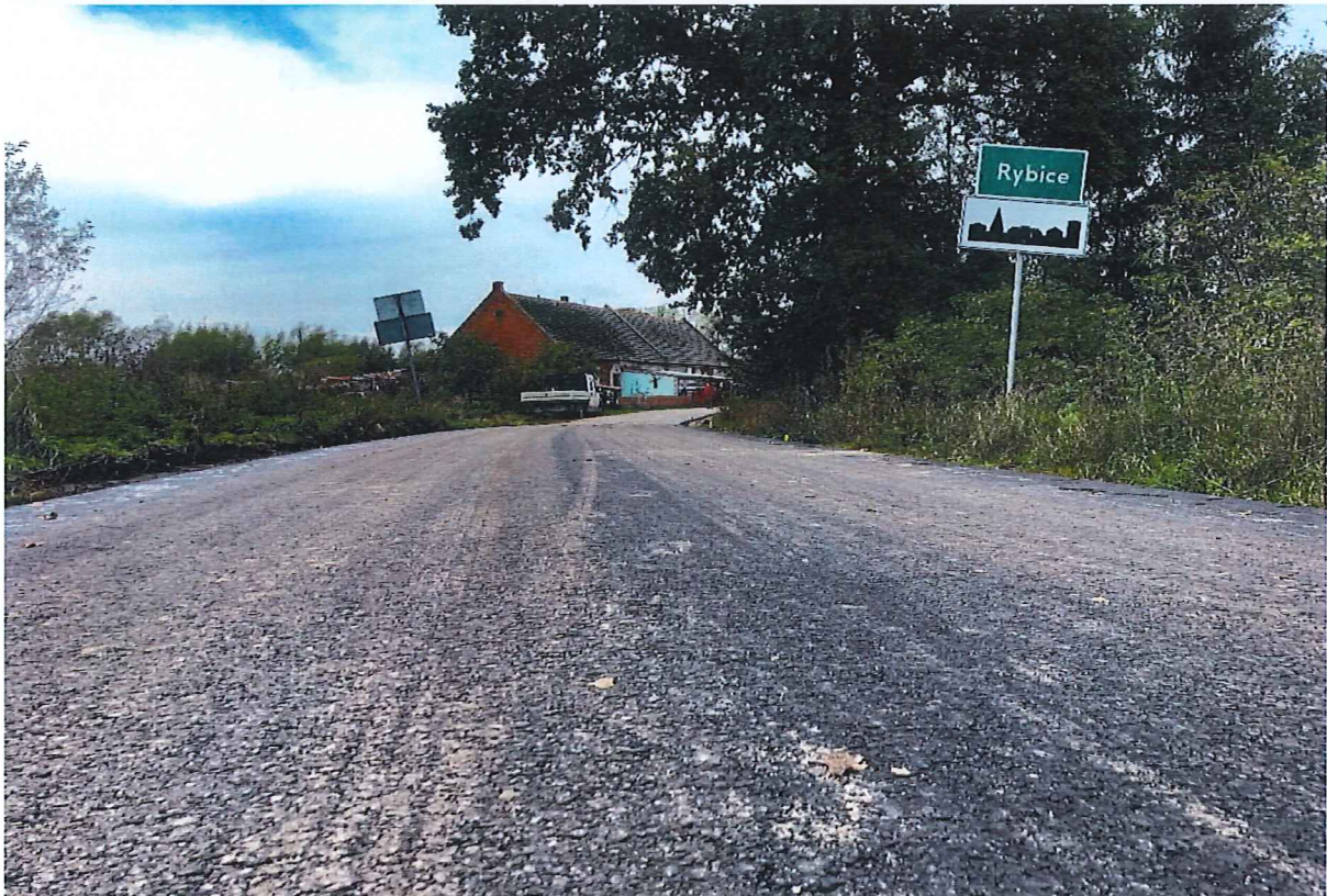
fot. wykonana nakładka asfaltowa w m. Rybice
