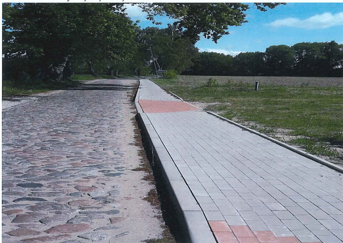
fot. budowa chodnika w miejscowości Jatki
