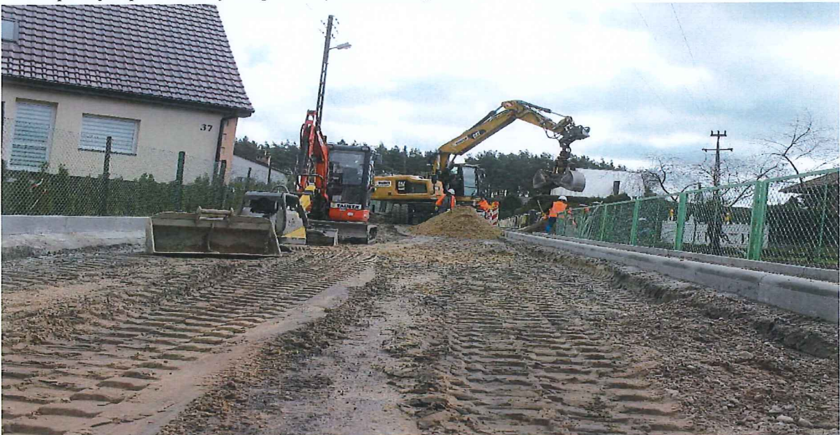
fot. rozpoczęcie przebudowy drogi w miejscowości Świerżno do stadionu
