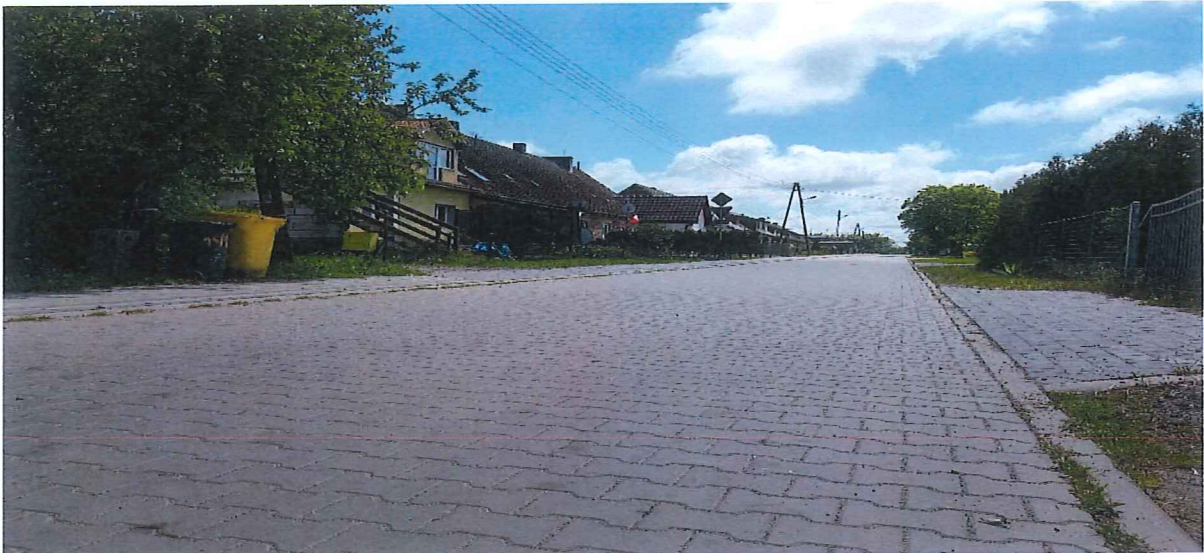
fot. zakończenie przebudowy drogi w miejscowości Sulikowo
