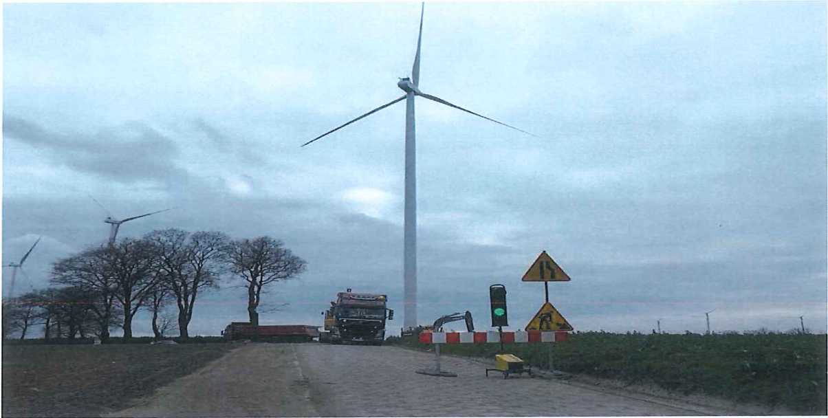
fot. rozpoczęcie przebudowy drogi w miejscowości Kępica
