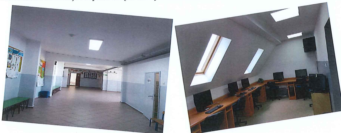
fot. remont budynku Szkoły Podstawowej w Świerznie
