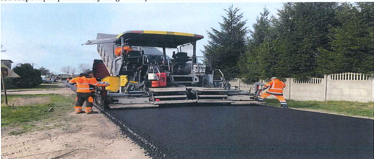
fot. remont drogi w miejscowości Świerżno do cmentarza
