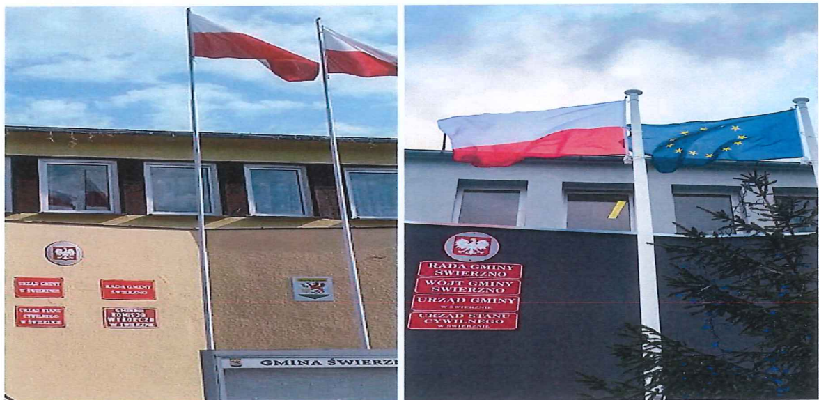
fot. termomodernizacja budynku Urzędu Gminy w Świerznie
