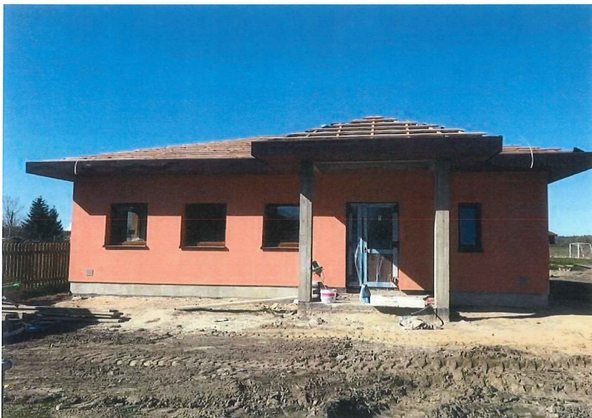
fot. budowa świetlicy wiejskiej w miejscowości Ciesław
